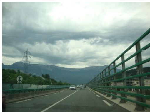
RN 85 : sur l'autopont de Jarrie En direction de Grenoble
