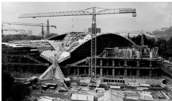
AMMG - Construction du Palais des Sports de Grenoble à l'occasion des JO de 1968
