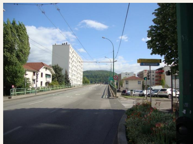
L'avenue Jean-Jaurès à Eybens : le franchissement de la rocade pénalise la continuité de cet axe urbain majeur
