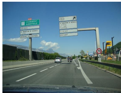
Rocade Sud : en approche de l'échangeur de Poisat En direction de l'est
