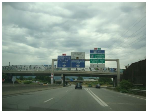
A480 : à l'approche du Rondeau En direction de Grenoble Ce secteur sera réaménagé dans le cadre du projet
