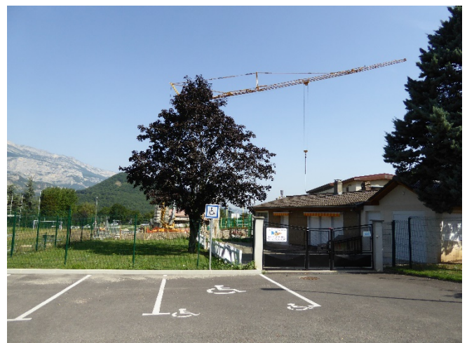
Travaux autour des équipements publics derrière la mairie, été 2017
