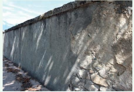
Mur de pierres et galets roulés enduit
