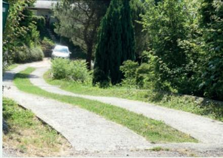
Bandes de roulement en béton, enherbement central - Herbeys - Le Châtelard
