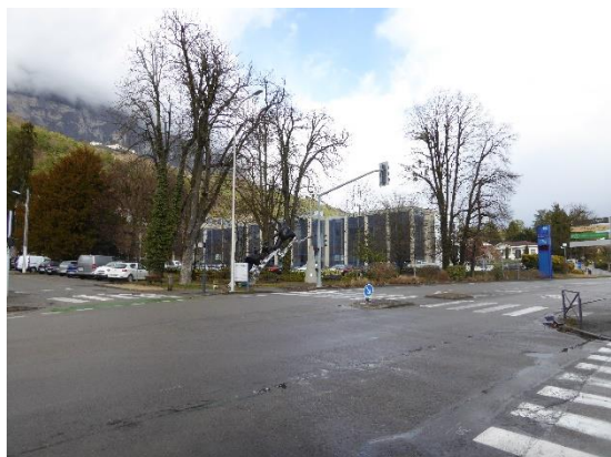
1 > vue sur l'angle de l'îlot Banque depuis l'avenue du Grésivaudan
