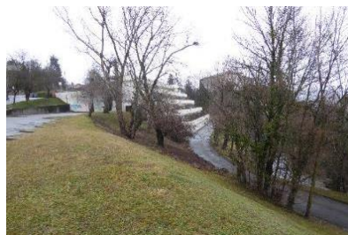
2 > Talus végétalisé et arboré
