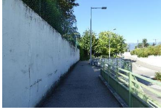
4 &gt; Cheminement piéton en contrebas, au nord
