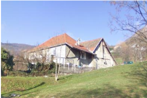
4 > Vue sur la maison existante
