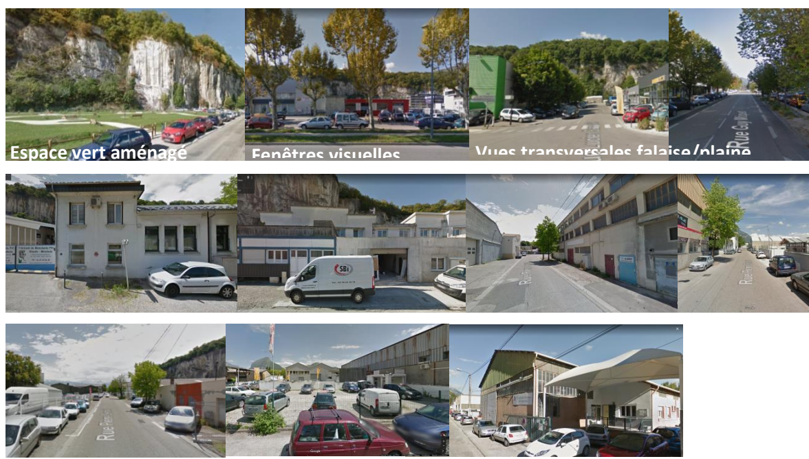
PERCEPTIONS DE LA FALAISE EXISTANTES UN ESPACE PUBLIC LAISSE BRUT ET DES BATIMENTS VÉTUSTES UN ESPACE AU SOL ENCOMBRÉ
