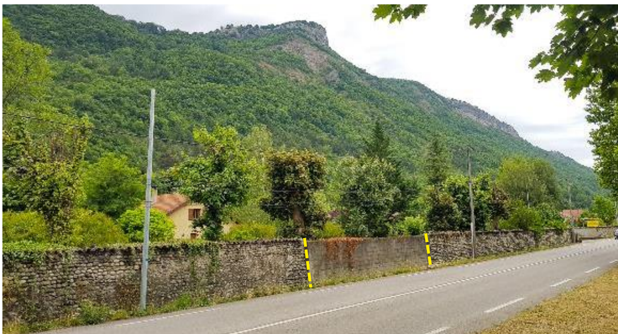
Possibilité de créer un accès sur une portion du mur déjà détruite puis reconstruite
