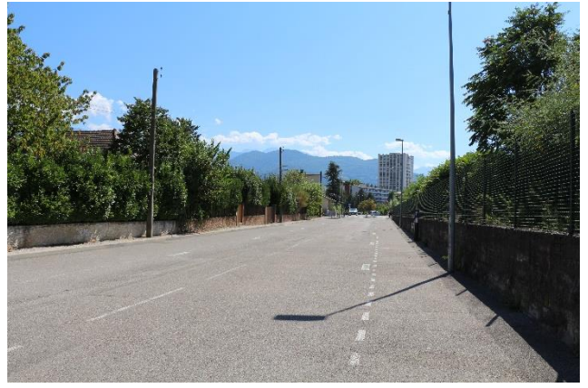
2 > Le chemin des Grenouilles, une voirie large et imperméable
