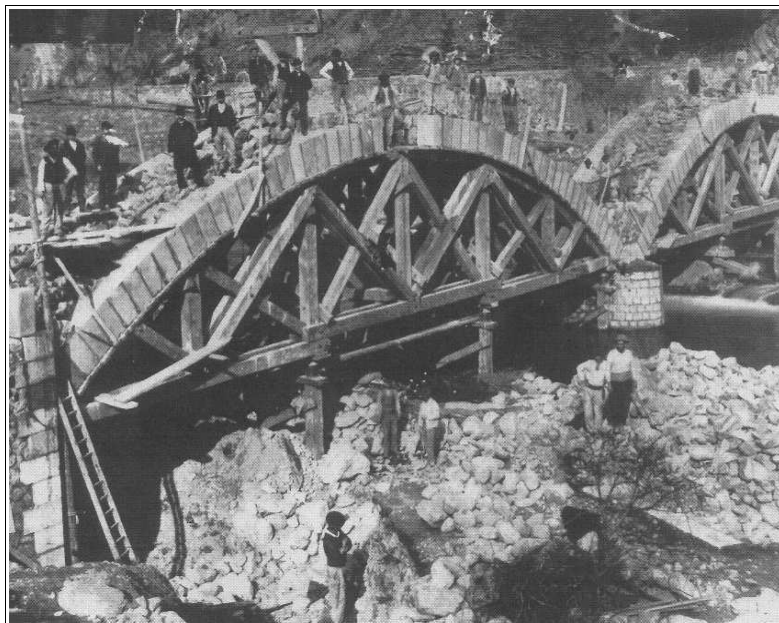
Photo 21 : Construction du Pont de l'Île Falcon en 1903. « Vizille – Regards vers le passé » - Gérard MINGAT et Roger MORARD – 2003.
