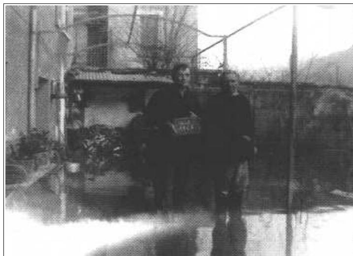
Photo 9 : Inondation de Septembre 1968 à Vizille. « Vizille – Regards vers le passé » - Gérard MINGAT et Roger MORARD – 2003
