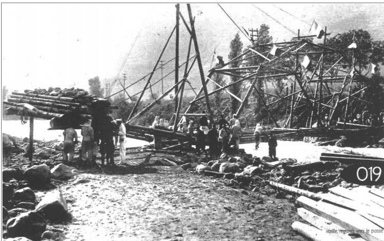
Photo 18 : Pont « Taron » construit en quelques heures au Péage de Vizille en Septembre 1911. « Vizille – Regards vers le passé » - Gérard MINGAT et Roger MORARD – 2003.
