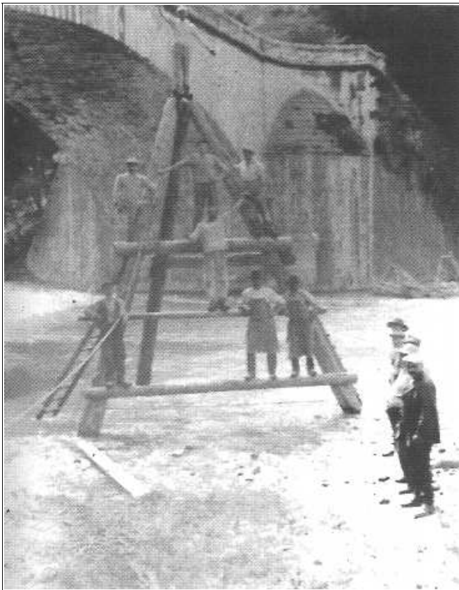
Photo 17 : Construction de cabrettes. « Vizille – Regards vers le passé » - Gérard MINGAT et Roger MORARD – 2003.
