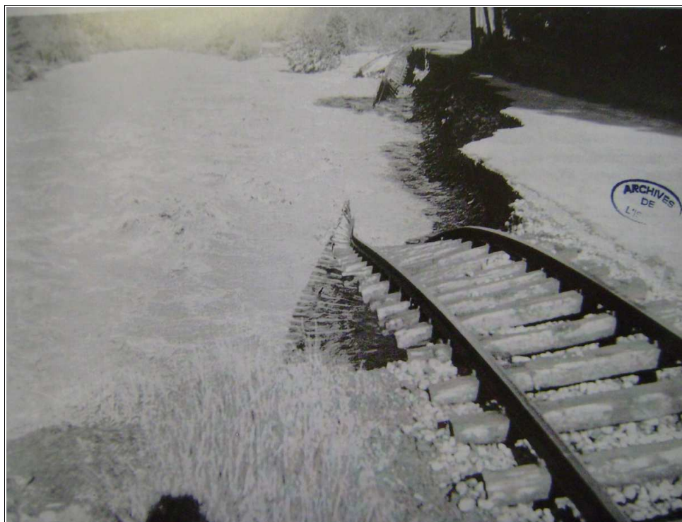
Photo 11 : La route en dessous des Rivoirants subie des dégâts lors d'une crue de la Romanche au début du Xxe siècle. « Vizille – Regards vers le passé » - Gérard MINGAT et Roger MORARD – 2003
