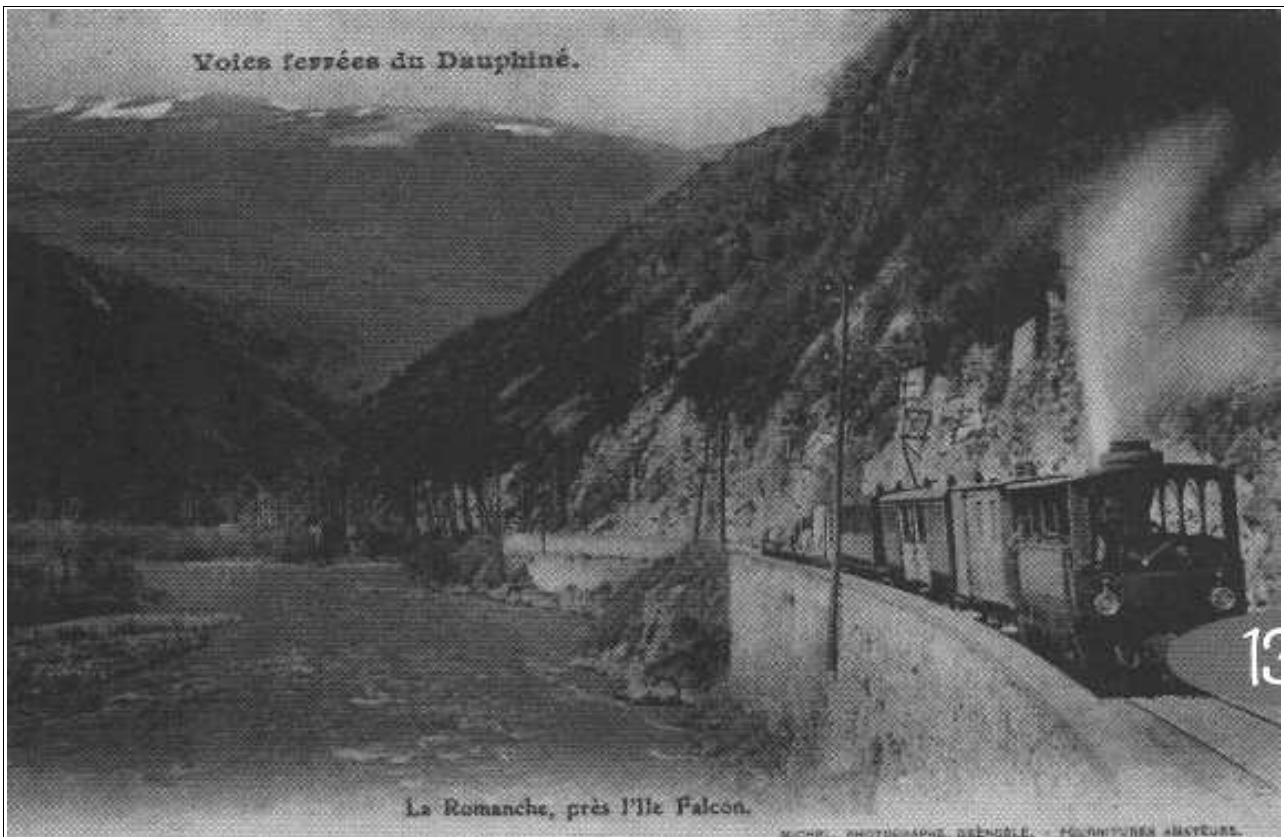
Photo 12 : Rive droite de la Romanche au niveau de l'Île Falcon au début du Xxe siècle. « Vizille – Regards vers le passé » - Gérard MINGAT et Roger MORARD – 2003. La photo permet d'estimer la hauteur de la route (sur laquelle circule le tramway) par rapport au lit mineur de la Romanche.
