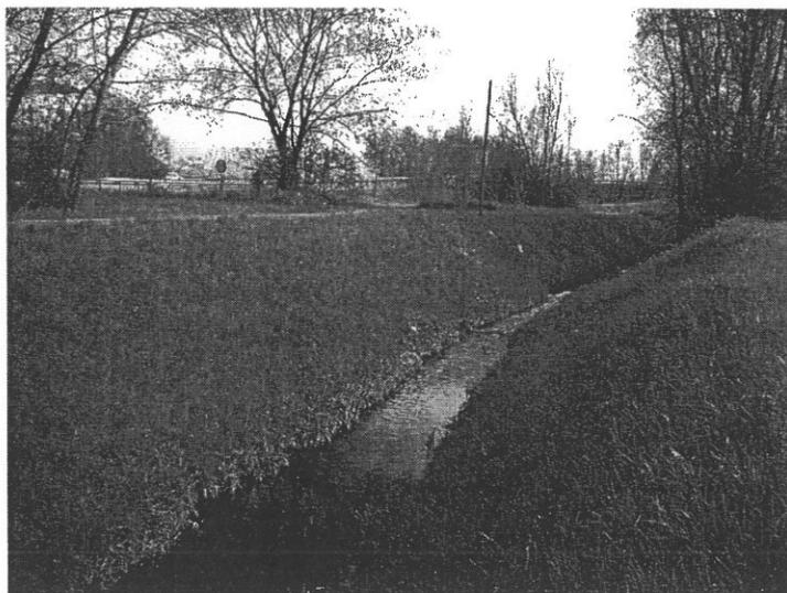
▪**Le contre-canal EDF** : Suite à l'aménagement de la retenue EDF de ST-EGRÈVE/NOYAREY, un contre-canal récupérant les fuites et sous-écoulements au travers des digues a été creusé depuis la confluence DRAC/ISÈRE jusqu'au site du barrage. Les eaux qui y coulent sont indépendantes du réseau de la BIOLLE et se rejettent directement dans L'ISÈRE en aval immédiat de la centrale hydroélectrique.
