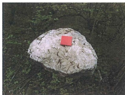
Bloc récent éboulé (sept 2003) : 1.5 m³ Chemin des Batteries – Amont du hameau de Clémencière
