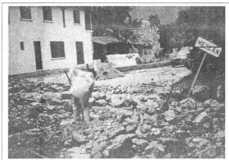
Une lave torrentielle a dévasté le chemin de l'Église le 25 mai 1988.
