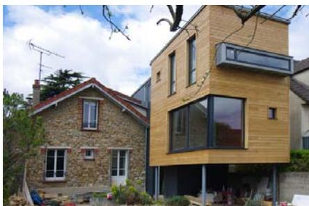
**Figure 124 : Exemple d'une rupture radicale des formes architecturales pour une adaptation au risque inondation : maison sur pilotis à Draveil (91) (source : <http://marc.lafagne.free.fr/nouveautes.html>)**
