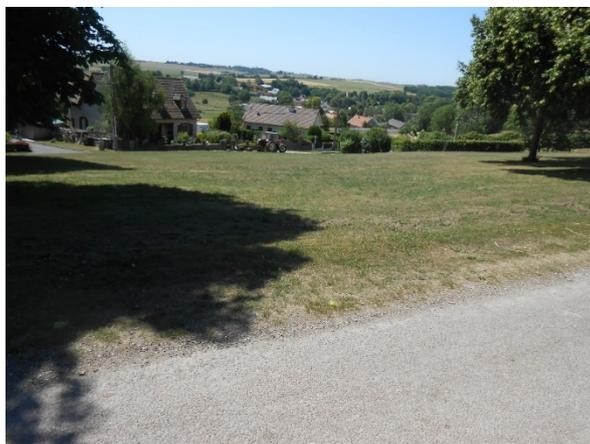
Figure 109 : Exemple d'absence de bordure permettant le ruissellement des eaux de voirie vers l'espace vert
