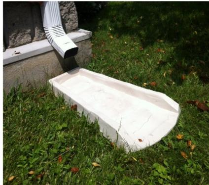
Figure 106 : Proposition de déflecteur préfabriqué pour éloigner les eaux de gouttière de la façade
