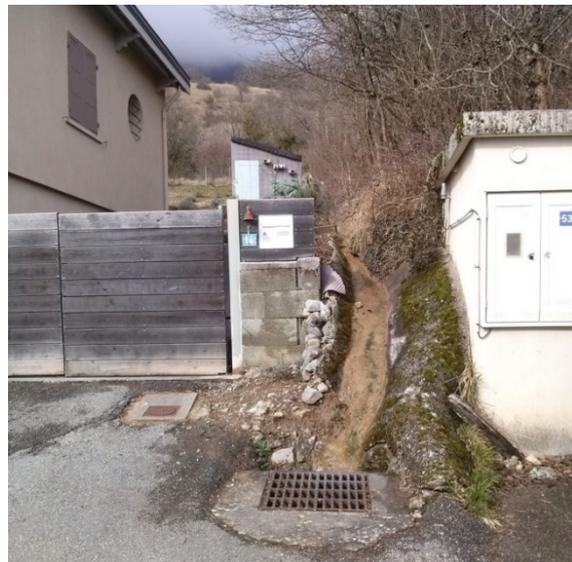
Figure 70 : Axe de ruissellement récupéré par le réseau enterré (eaux pluviales ou ruisseau busé) à son entrée en zone urbanisée (commune de Meylan)
