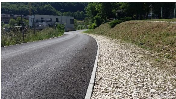
**Figure 100 : Exemple d'infiltration des eaux de voirie dans les accotements à Pré Nouvel (Seyssins)**
