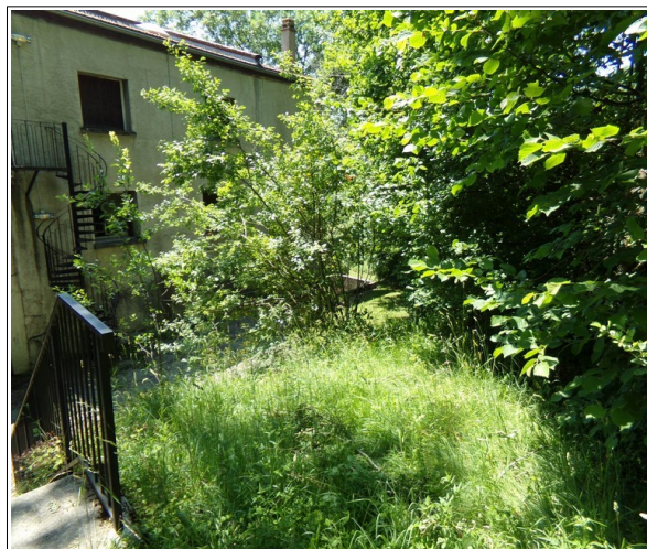
Photo 8: bâtiment du centre aéré de la ville de Grenoble situé au débouché d'un axe d'écoulement.
