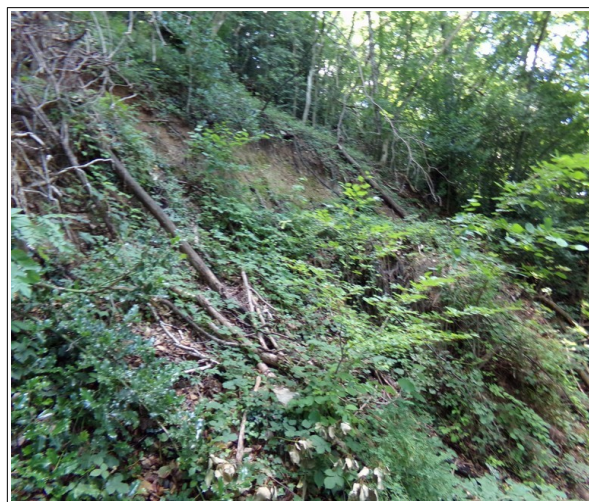
Photo 14: pentes très fortes du versant de La Rivoire et signes d'instabilité.
