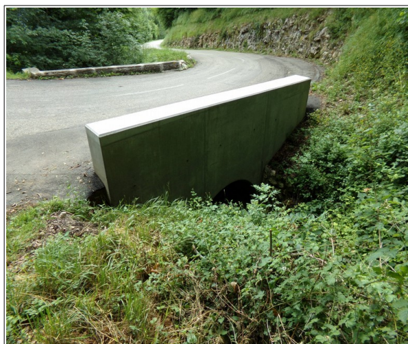
Photo 5: franchissement de la RD105d par le ruisseau de Lanfrey (ouvrage étroit).
