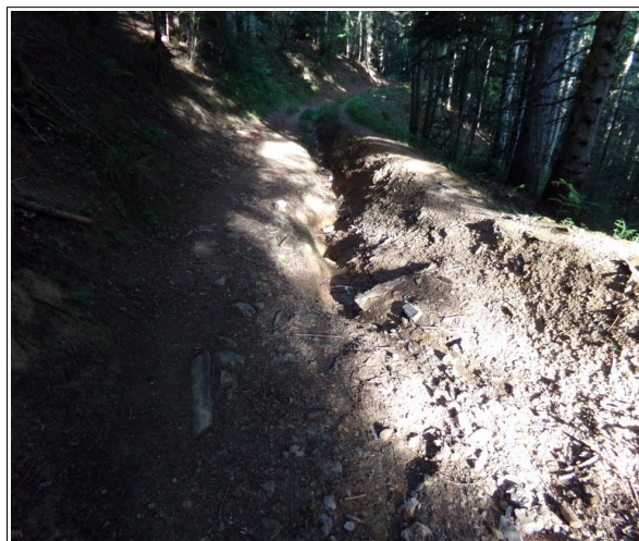
Photo 10: phénomène de ravinement sur le sentier du Pas-de-l'Âne.
