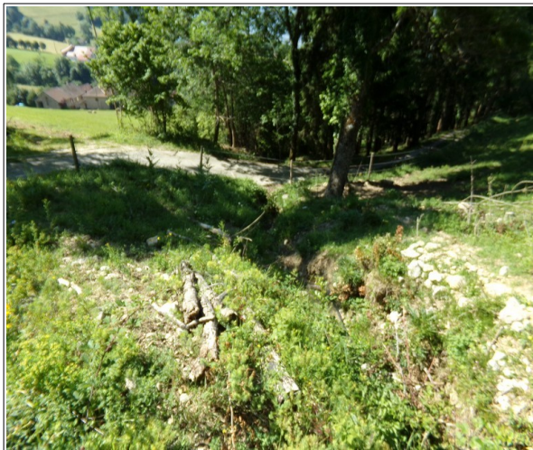
Photo 7: Combe-d'Espagne. On notera l'érosion provoquée par les écoulements.
