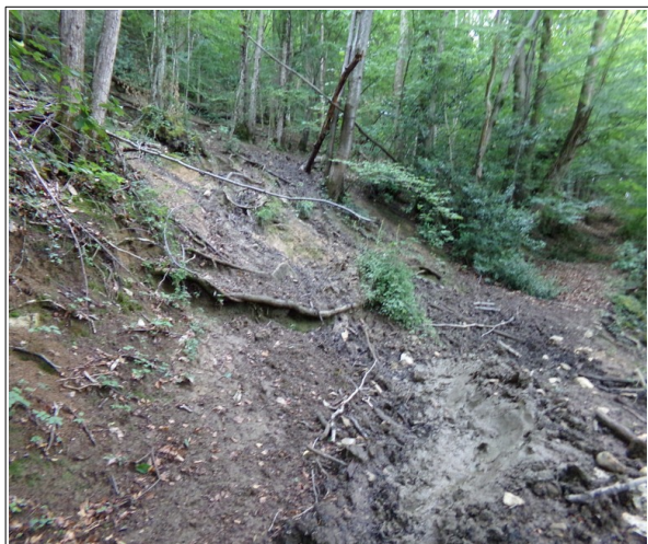
Photo 15: zone instable à l'amont de la combe drainant l'extrémité sud de la commune. On notera la source saturant le terrain.
