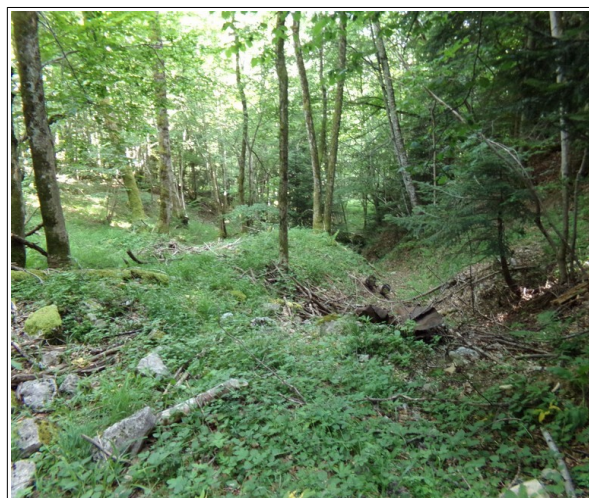
Photo 2: combe supérieure du ruisseau de Lanfrey encombrée par des dépôts torrentiels. On notera les volumes importants de matériaux.
