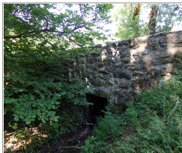
Photo 4: franchissement de la route de Colavière et Namière par le ruisseau de Lanfrey (ouvrage étroit).
