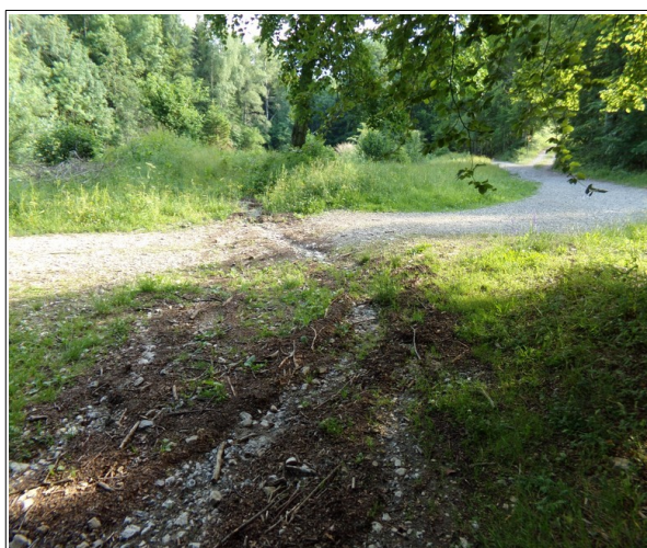
Photo 11: traces de ruissellements sur le sentier du Pas-de-l'Âne à la hauteur du chemin des Captages.
