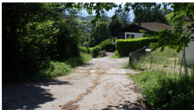
Photo 7 : Traces de ruissellement sur le chemin des Fontanettes.
