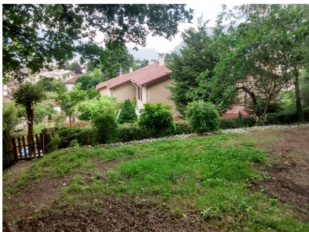
Photo 3: Bourrelet de cailloux à l'amont de la construction de l'allée Flora Tristan. Par le passé les écoulements de faible hauteur se sont étalés de part et d'autre du bâtiment (parcelle AC52).
