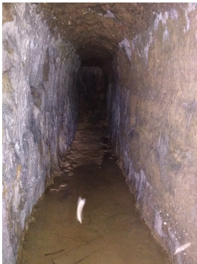
Photo 7: Galerie de recherche d'eau du Ruisselet.
