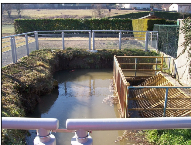
Photo 12: L'ouvrage d'entonnement du ruisseau de Montavie.
