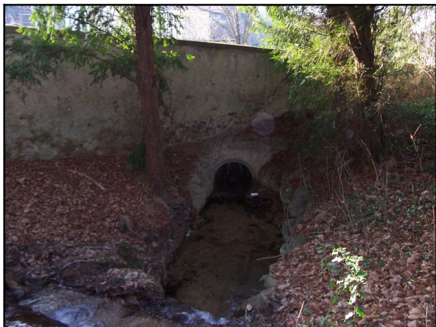
Photo 3: La buse assurant le franchissement de l'enceinte du parc du château et de la rue de l'Église.
