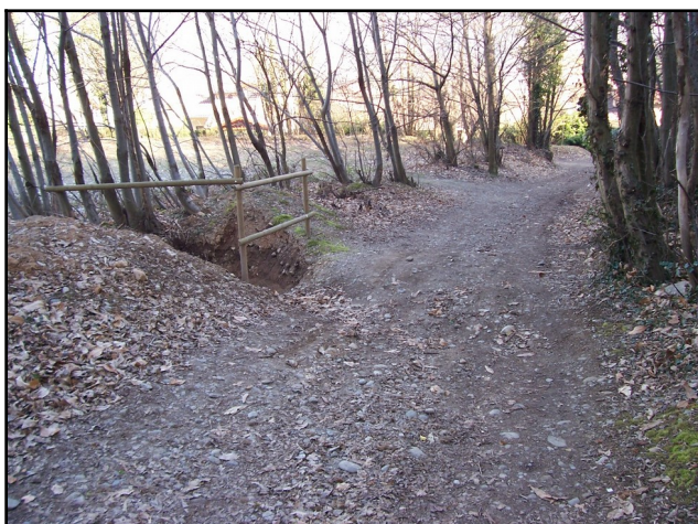
Photo 15: Ouvrage de lutte contre le ruissellement et le ravinement (secteur de l'Oratoire).
