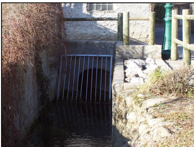
Photo 10: L'ouvrage d'entonnement sous la zone bâtie (amont de la propriété Chavant).
