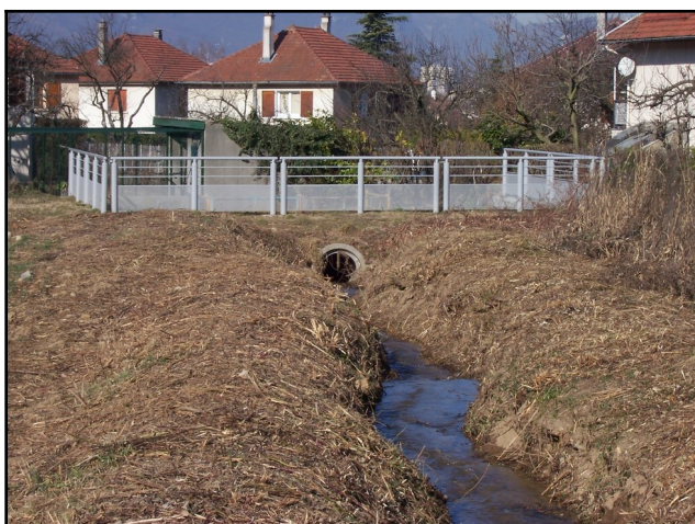
Photo 11: L'ouvrage d'entonnement du ruisseau de Montavie à Pré-Bresson (vue de l'amont).
