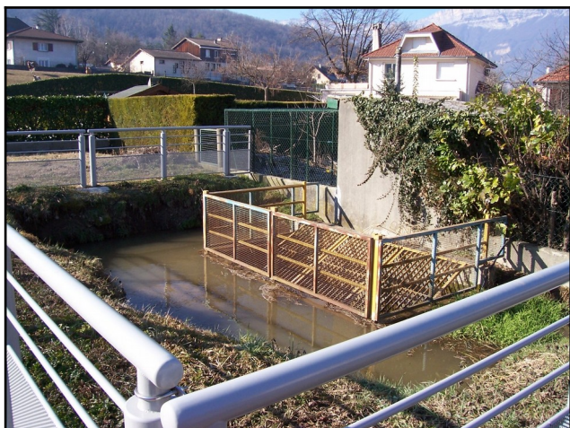
Photo 5: L'ouvrage d'entonnement du ruisseau de Montavie à hauteur de Pré-Bresson.
