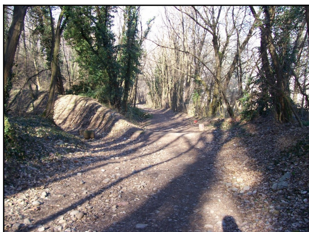
Photo 16: Ouvrage de lutte contre le ruissellement sur le chemin d'Echirolles à Jarrie.
