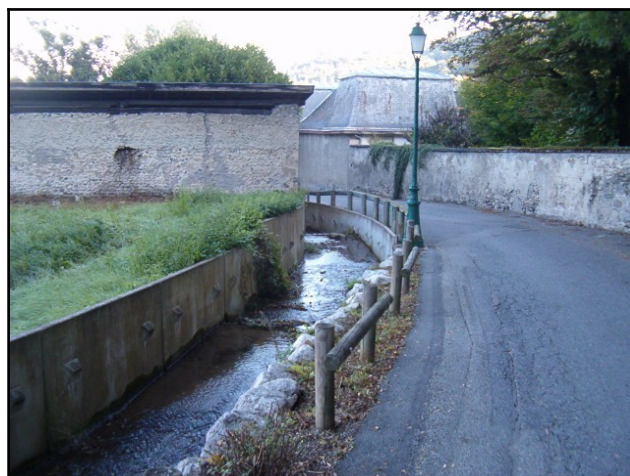
Photo 4: Le chenal du ruisseau de Montavie le long de la route, à l'aval du parc du château.
