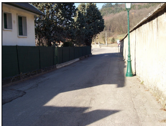
Photo 8: Partie basse de la rue de l'Église. La chaussée est adaptée pour limiter les divagations torrentielles.
