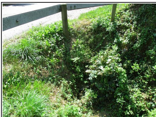
Photo 6: entrée de buse en partie obstruée par la végétation, route du Conest
