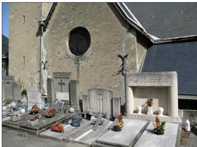
Photo 24: Fissures apparentes sur les murs de l'Église et façades renforcées par des clefs.
