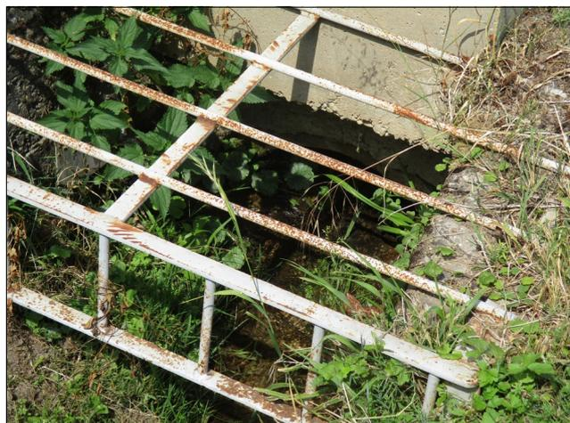
Photo 9: Grille de protection amont de la buse
