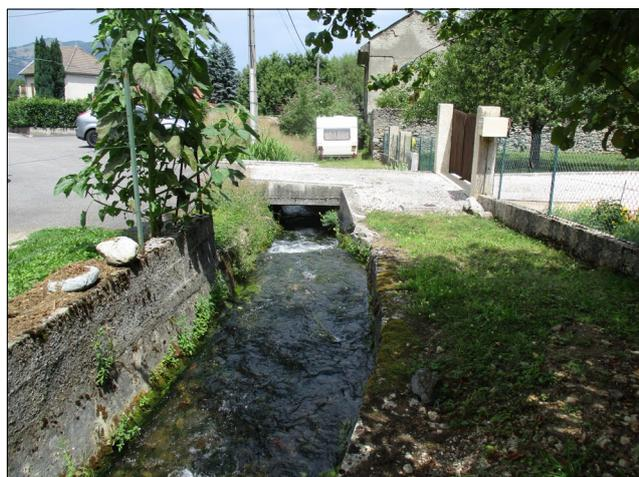
Photo 17: Pont en béton laissant une faible capacité hydraulique
