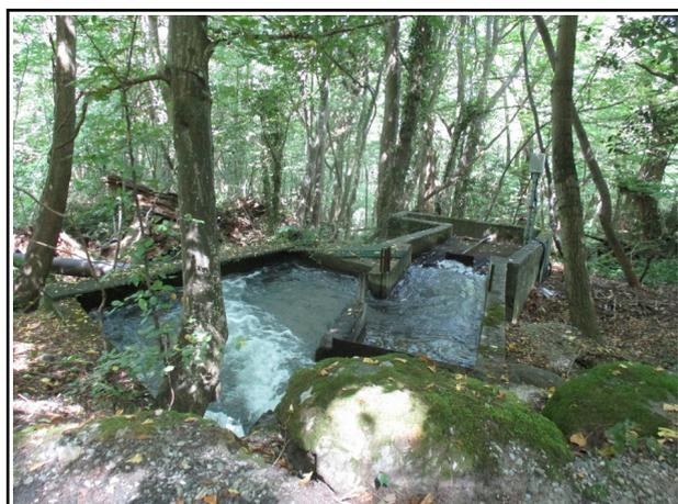
Photo 5: prise d'eau entre la centrale électrique de Loula et le ruisseau du Moulin
