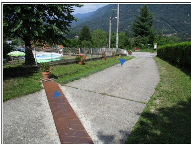
Photo 8: Passage du ruisseau sous la grille et le long de la voie d'accès aux propriétés.
