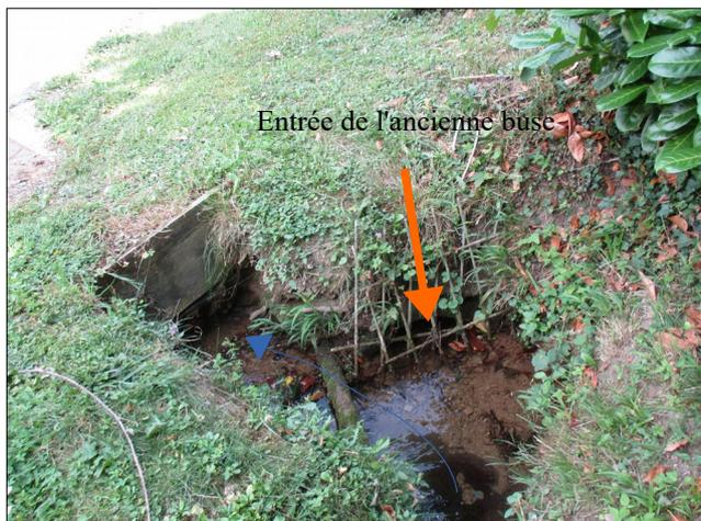
Photo 7: Ancienne buse obstruée, déviation du ruisseau dans un chenal sous la route
