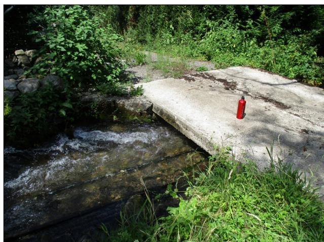
Photo 15: Pont en béton laissant une faible capacité hydraulique
