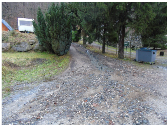
Photo 18: Ruissellement sur un chemin d'accès dans le secteur des Gavets (parcelle 815) - AGR - Janvier 2018
