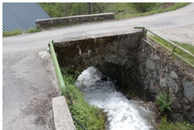
Photo 8: Ouvrage de franchissement ancien, immédiatement à l'aval de la passerelle béton. On remarquera le dimensionnement largement supérieur de l'ouvrage.
