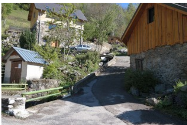
Photo 7: Passerelle béton sur le Bruyant permettant l'accès à deux habitations en rive droite. Les débordements sont canalisés par la chaussée béton en rive gauche.
