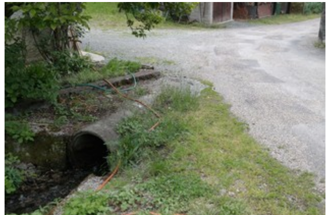
Photo 2: Buse du ruisseau de l'Enfant, facilement colmatable par des flottants.
