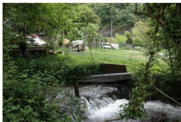
Photo 10: Prise d'eau d'un ancien canal d'irrigation au niveau du château. En cas de forte crues, les débordements peuvent emprunter le bief.
