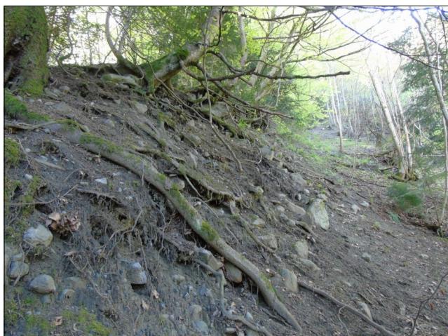
Photo 3 : Ravinement dans les moraines et colluvions constituant les terrains de couvertures instables du glissement de terrain du Prémol.
