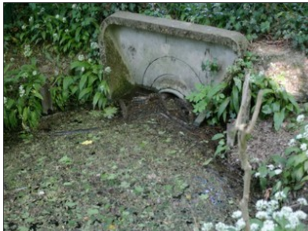
Photo 2: Ouvrage de franchissement du ruisseau de la Frange Verte au niveau de la rue Guy Moquet
