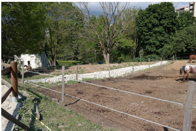
Photo 3: Aménagements du centre équestre afin de limiter les ruissellements (drain, bute en terre)
