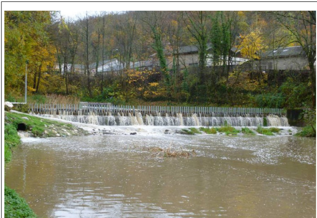
Illustration 2: Plage de dépôt en novembre 2014, peigne obstrué sur 50% de sa hauteur
