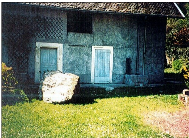
Photo 7 : Bloc éboulé à Champrond en 1997 (photo Mécanroc).
