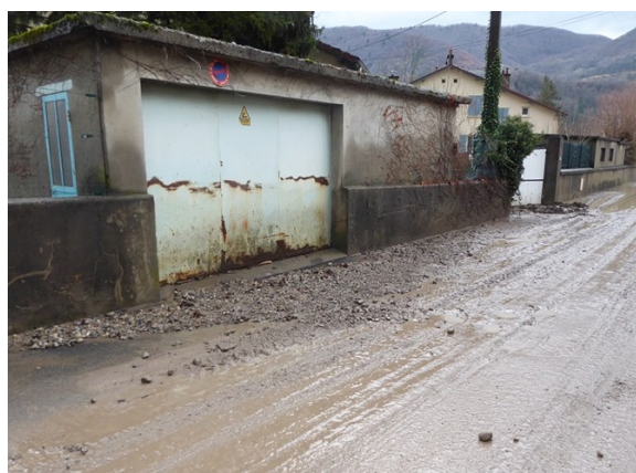
Photo 15: Rue des jardins couvertes de boue suite au débordement du ruisseau de Combe Noire, le 4 janvier 2018
