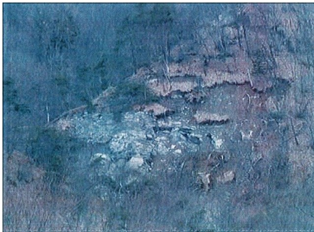
Photo 1 : Glissement de terrain dans le versant du Jonier à l'amont de Revolleyre en février 2015 (photo RTM).
