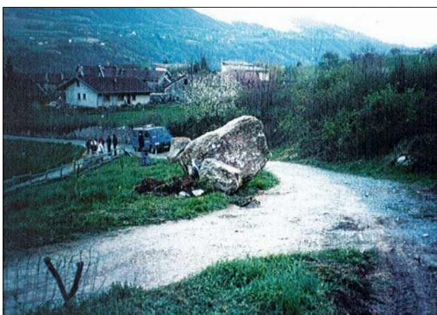
Photo 6 : Blocs éboulés à Champrond en 1997 (photo Mécanroc).
