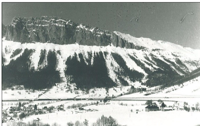
Photo 11 : Panorama du versant à l'amont de Prénelfrey suite aux avalanches de janvier 1981 (photo RTM).
