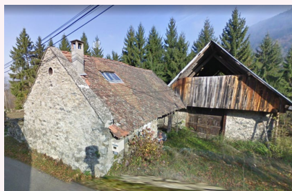
Bâtiment repéré parcelle n°384
