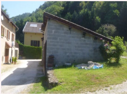
Bâtiment repéré parcelle n°572
