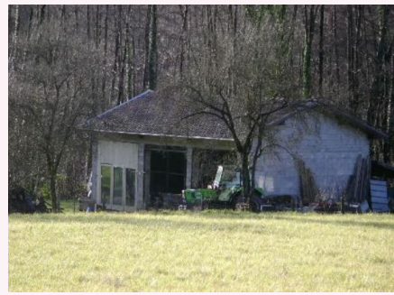
Bâtiment repéré parcelle n°572
