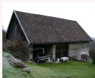
Bâtiment repéré parcelle n°399
