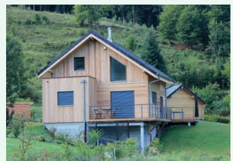
Construction récente épousant le relief par surélévation - Le Sappey-en-Chartreuse
