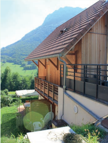
Coursive et dépassé de toiture Toiture supérieure à 70% - Quaix-en-Chartreuse
