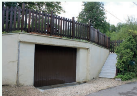
Garage intégré dans le mur de soutènement - Le Sappey-en-Chartreuse - Privilégier une structure plus simple. Cf ci-contre
