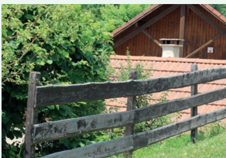
Barrière à lisse horizontale en bois - Saint-Martin-le-Vinoux
