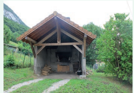
Petit patrimoine : four, structure ouverte - Saint-Martin-le-Vinoux
