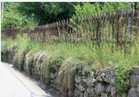
Mur en pierres, absence de joints, palissade bois ajourée et végétation - Proveysieux
