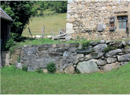
Association de pierres de différents calibres et joints creux - Mont-Saint-Martin
