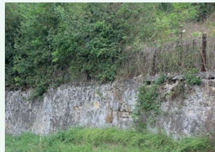
Muret de soutènement - Saint-Martin-Le-Vinoux
