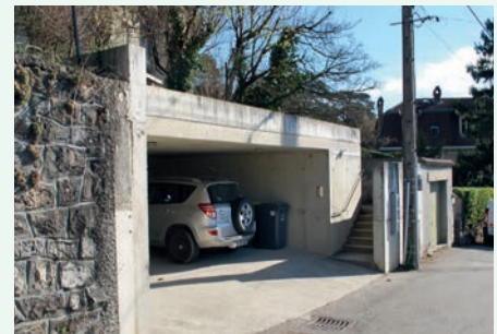
Garages intégrés dans le mur de soutènement - Référence extérieure au territoire «Chartreuse» (La Tronche)
