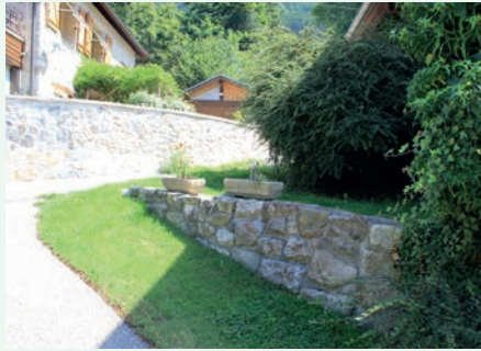
Muret de remblais avec pied et tête végétalisée - Mont-Saint-Martin
