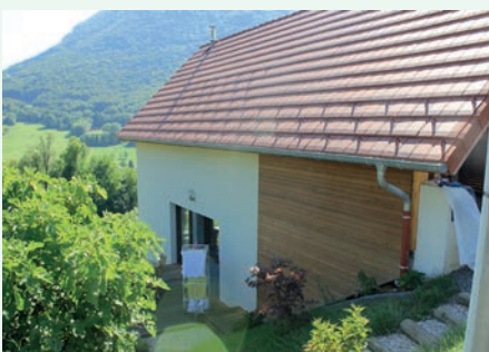
Construction récente encastrée dans la pente - Proveysieux
