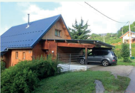
2 places de stationnement couvertes et accolées au bâtiment - Le Sappey-en-Chartreuse
