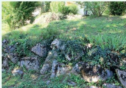
Implantation dans la pente avec muret de soutènement en pierre et talus - Quaix-en-Chartreuse
