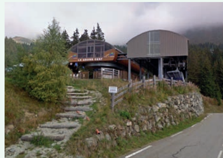
Mur de soutènement et accès par cheminement - Référence extérieure au territoire «Chartreuse» (Les 7 laux - Source : google)
