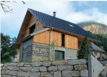
Bois et mur machefer (réhabilitation) en pans horizontaux - Le Sappey-en-Chartreuse
