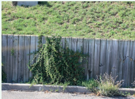
Muret en bois et talus enherbé avec bande végétalisée en pied - Quaix-en-Chartreuse
