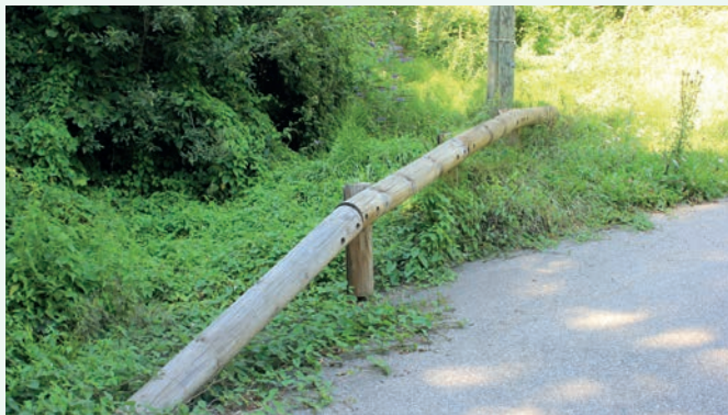
Glissière de sécurité en bois - Mont-Saint-Martin
