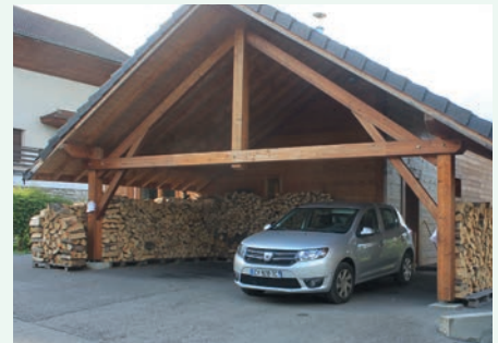
Garage en structure poteau-poutre en bois - Le Sappey-en-Chartreuse
