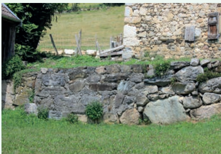
Appareillage rustique, hétérogénéité de l'appareillage - Mont-Saint-Martin
