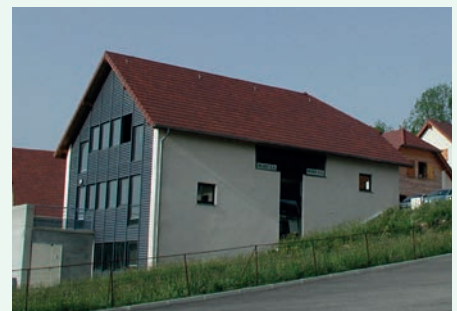
Bâtiment artisanal - Référence extérieure au territoire «Chartreuse» (Miribel Lanchâtre)
