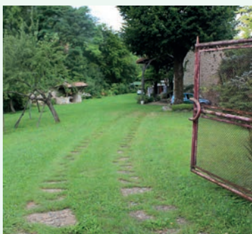
Bande de roulement enherbée et dalles - Saint-Martin-le-Vinoux
