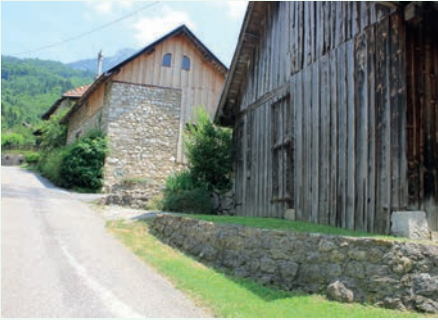
Implantation dans la pente avec léger terrassement, rapport à la rue et muret de soutènement en pierre - Proveysieux
