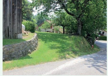
Murets et talus - Proveysieux
