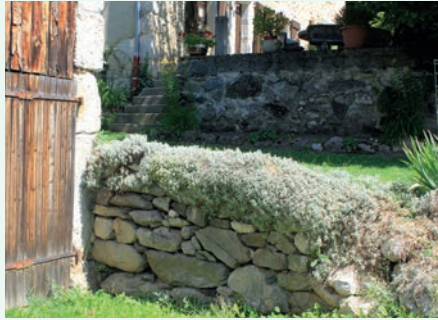
Fractionnement de la pente par succession de terrasses de faible hauteur - Mont-Saint-Martin
