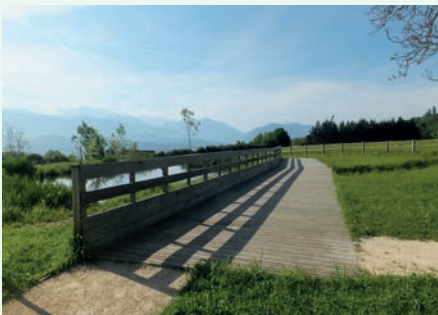
Passerelle bois - Référence extérieure au territoire "Chartreuse" (Les Vouillants, Seyssinet)
