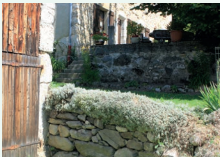
Fractionnement de la pente par succession de terrasses de faible hauteur - Mont-Saint-Martin
