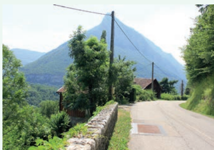
Bâti en contrebas de la route - Proveysieux
