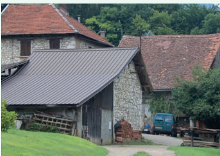
Façade ouverte réduisant l'importance du volume - Saint-Martin-le-Vinoux
