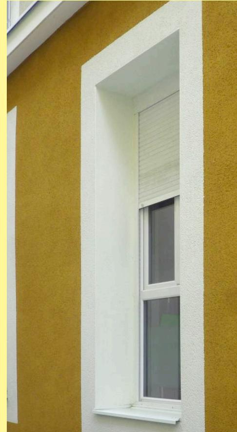
**X** Les appuis de fenêtre en tôle pliée font perdre un élément important de modénature de la façade et la banalise
