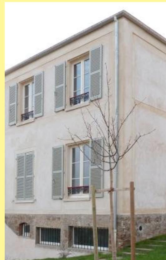
*Façade d'un immeuble traitée avec un enduit isolant à base de chaux, reproduisant la modénature d'origine.*
