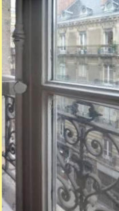
Le vitrage simple ancien a été remplacé par du double vitrage. La modification simple permet de conserver les menuiseries anciennes.
