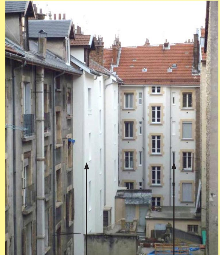
**X** Façade sur cour entièrement recouverte d'une isolation extérieure par plaques rapportées ayant fait totalement disparaître la modénature d'encadrements de fenêtres en ciment moulé.
