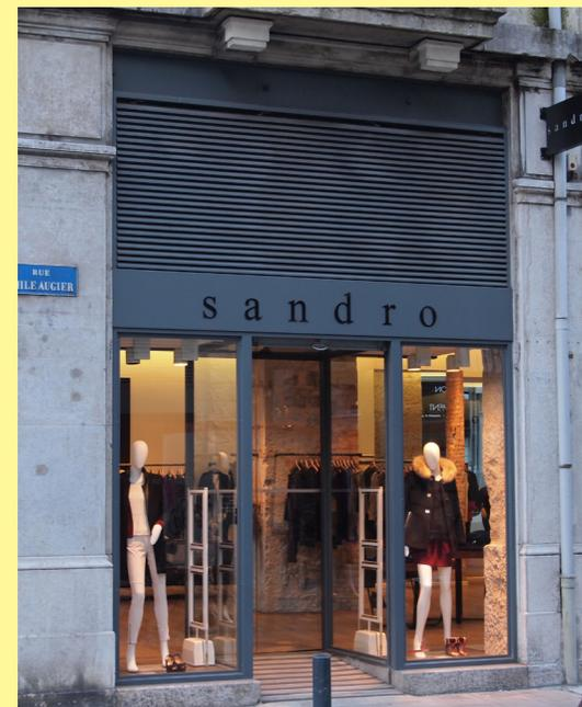
✓ Le système de climatisation est dissimulé derrière une grille bien intégrée à l'ensemble de la vitrine.
