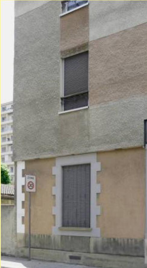
**X** Disparition des encadrements de fenêtre et les chaînes, bordure inférieure de l'isolant sans rapport avec l'architecture
