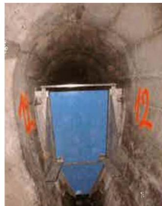
Figure 18 : Présentation de vanne pivotante
