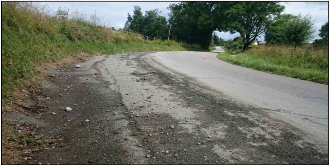
Photo 17: Engravement dû aux ruissellements sur les pentes de la rue de Pontenin.
