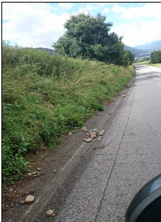
Photo 15: Dépôts de pierres d'un assez gros diamètre suite à de forts ruissellements.
