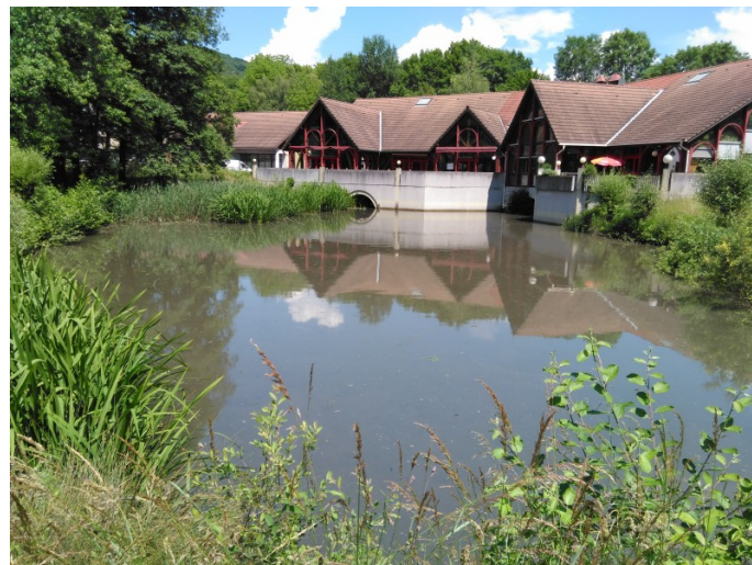
Photo 8: L'étang artificiel à l'aval du Collège et du restaurant interentreprises. Point de confluence du Saint-Didier et du Malega
