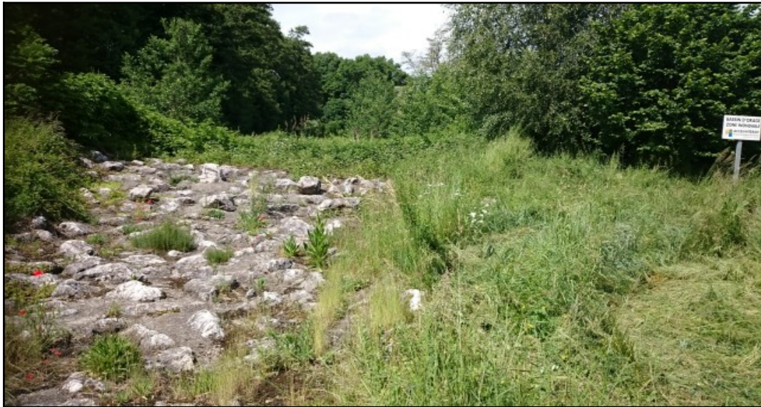
Photo 5: Déversoir de crue du bassin d'orage de Bon-Repos
