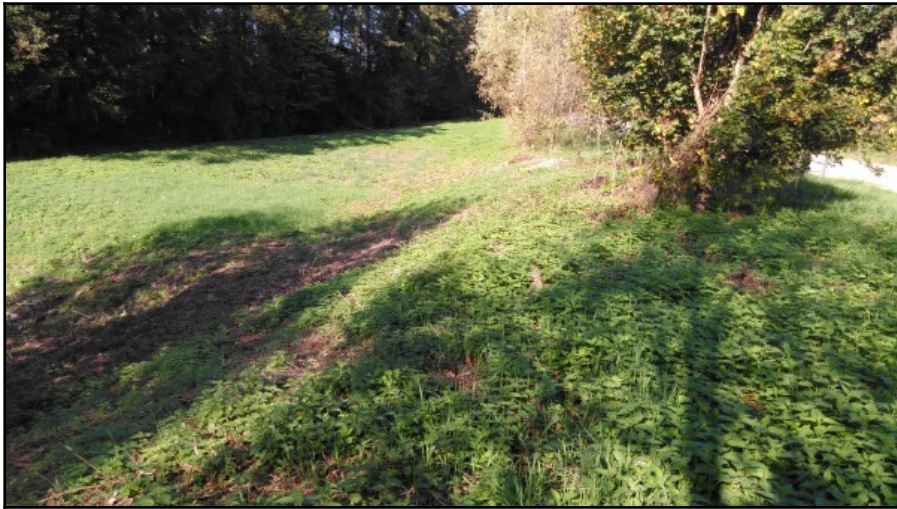
Photo 13: Bassin de rétention de Bon-Repos
