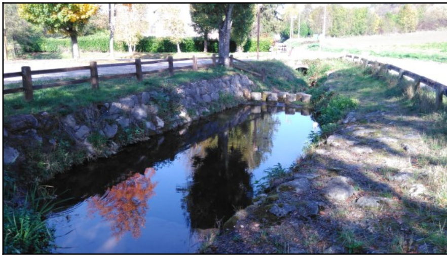
Photo 14: Bassin de décantation du Clos-Jouvin
