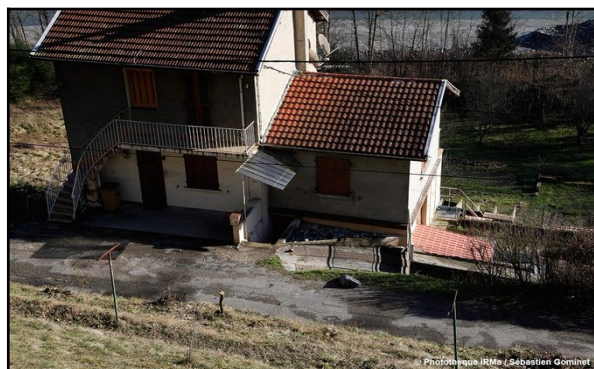
Photo 5: Bloc de 5l arrivé sur la route des Plâtrières suite à l'éboulement du 3 janvier 2015 – source IRMA
