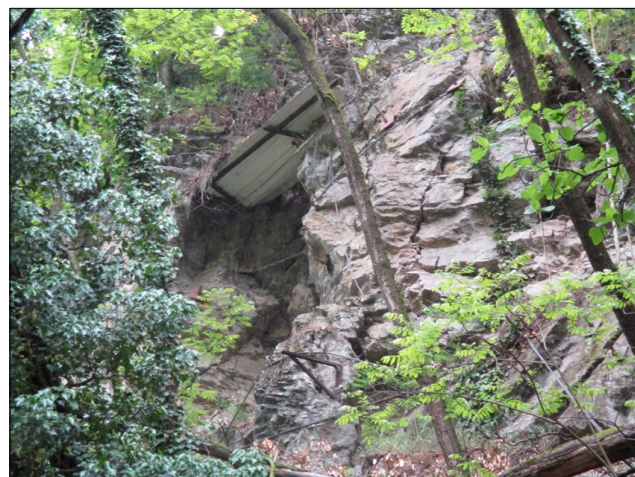
Photo 16: Ancrages à l'amont de la route des Plâtrières
