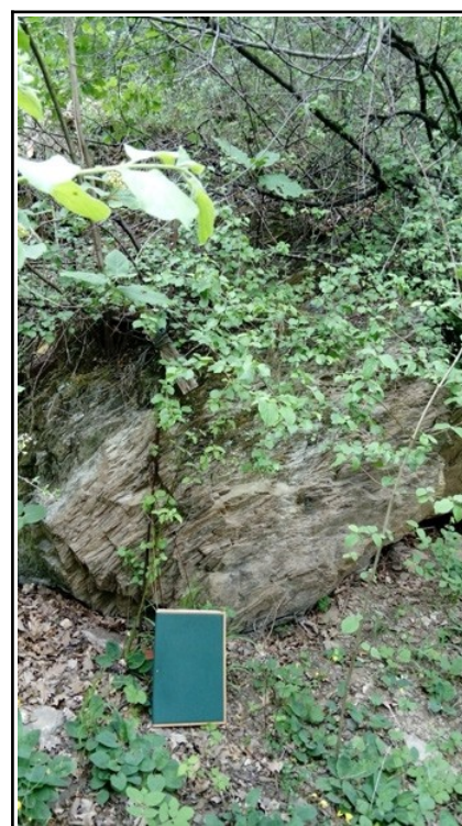
Photo 7: Bloc pouvant potentiellement basculé dans le versant
