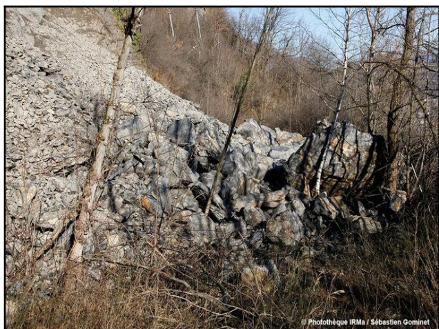
Photo 6: Éboulement du 3 janvier 2015 – source IRMA
