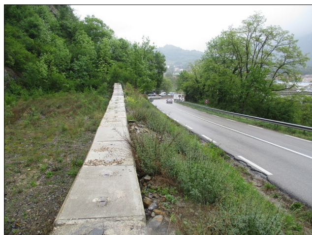
Photo 18: Muret en béton le long de la RN85
