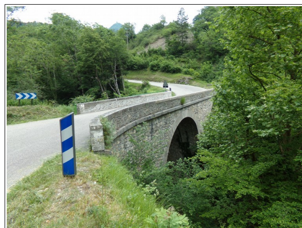
Photo 6: pont aval du Tenaion (RD105a) à l'aval immédiat de l'ancienne route. On notera son dimensionnement plus conséquent que l'ancien pont.
