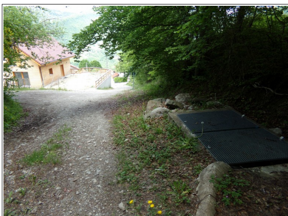
Photo 9: axe d'écoulement possible débouchant dans le hameau de La Frette. A droite, on distingue l'ouvrage d'un trop plein de réservoir d'eau.
