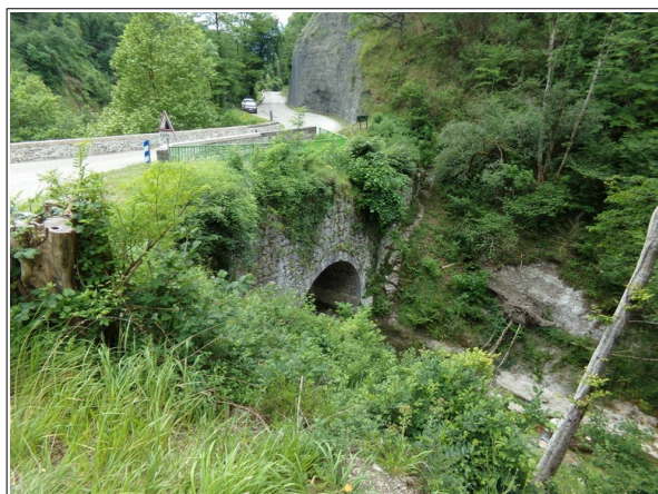
Photo 5: pont amont du Tenaion (ancienne route). On notera l'ouverture plutôt réduite.
