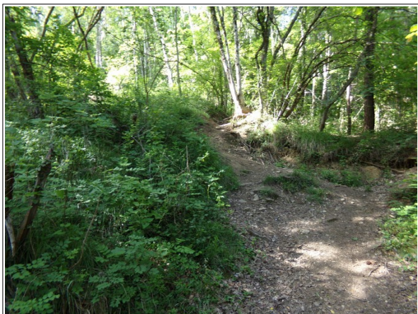
Photo 14: glissement de terrain à l'aval de la route de La Méarie (au droit de la falaise de La Raviolle). La route est touchée ainsi qu'un espace boisé.
