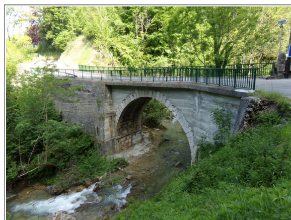
Photo 8: pont-de-Quaix. On notera son importante ouverture.
