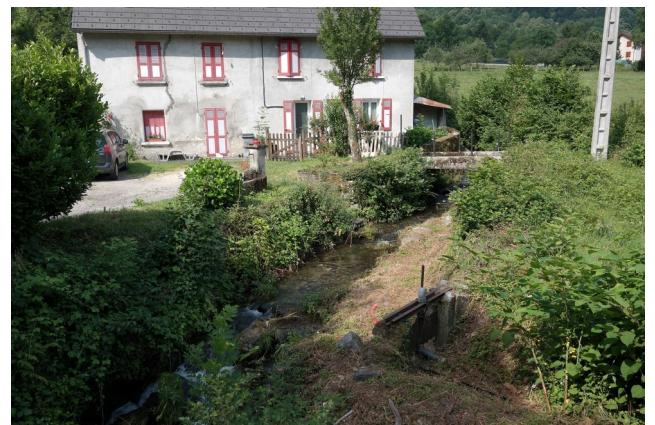
Photo 4: Secteur Gauthier, construction le long du ruisseau du Guérimont, exposée aux débordements.
