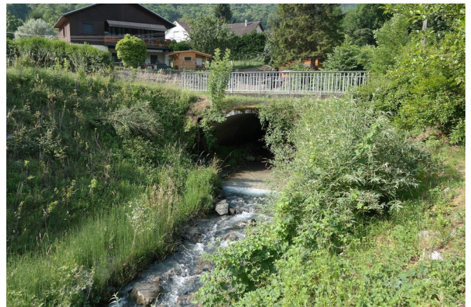
Photo 2: Pont du Granf Rif à la cote 410.
