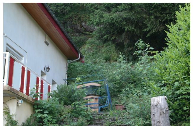
Photo 6: Escarpement (4 à 5 m) à l'arrière d'une construction de Belle Lauze.
