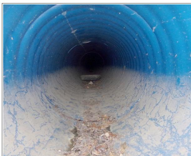
Photo 3: pneu coincé dans le busage supérieur de la plateforme des Houillères. On notera la laisse de crue (traces de boue) témoignant du fonctionnement de l'ouvrage.
