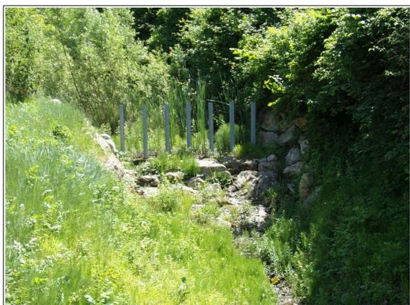
Photo 15: plage de dépôt et piège à flottants du Ravinon à l'amont de l'avenue de la Liberté. On notera la végétation abondante.
