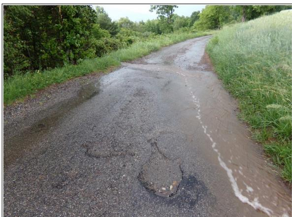
Photo 18: renvoi d'eau sur la route du col de La Chal dirigeant les écoulements en direction de la combe des Chabous.
