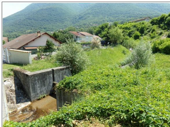
Photo 14: Plage de dépôt et endiguement du ruisseau des Chaussières entre la RD63a et la plateforme ferroviaire.
