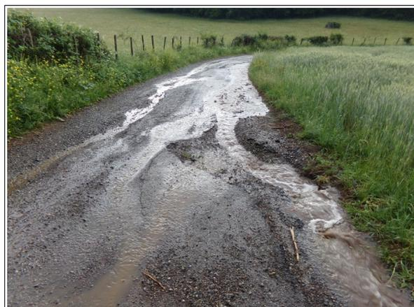
Photo 16: important ruissellement sur la route du col de La Chal. La photo a été prise après une pluie peu intense et de courte durée, donc bien après le pic de ruissellement. Les traces sur la route montrent que la lame d'eau peut occuper une plus large emprise, notamment en cas de fort orage.
