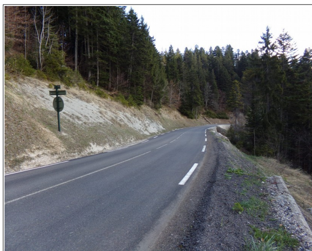
Photo 8: mur de soutènement dans le talus aval de la RD512 au niveau du Col de Porte.
