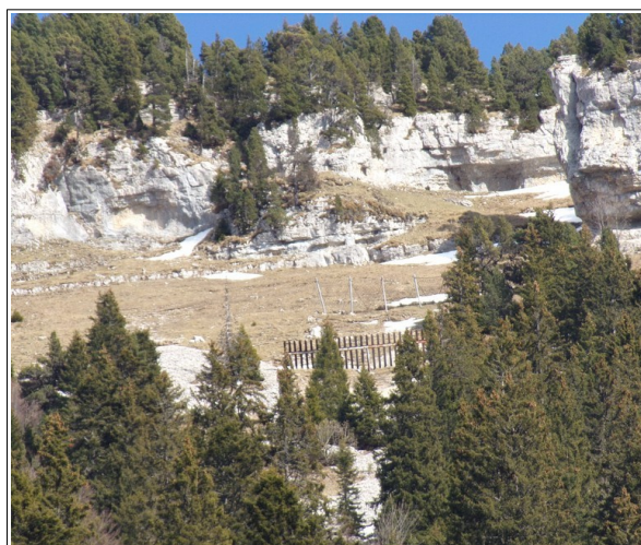
Photo 21: râtelier au niveau d'un couloir secondaire potentiellement avalancheux. En arrière plan, on distingue également un filet pareblocs.
