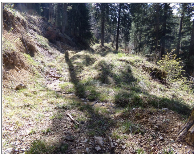
Photo 9: zone chahutée à l'aval de la RD512 et présence d'eau (piste forestière à l'origine du glissement de 1990).
