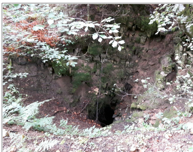
Photo 15: observation d'un fontis au lieu-dit La Charmette.
