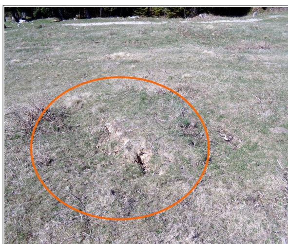
Photo 17: signe d'affaissement sur les pistes de ski du Habert du Col de Porte.
