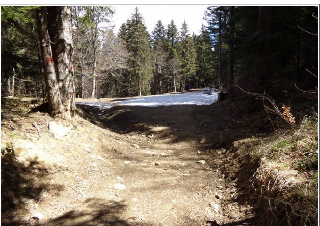
Photo 5: chemin de La Pinéa sujet aux écoulements. Un fossé faiblement marqué est aménagé. Un étalement de l'eau sur la plateforme enneigée reste possible.
