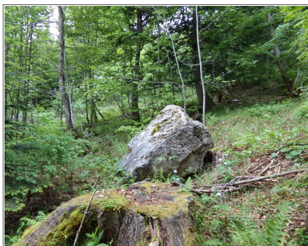
Photo 13: présence de blocs au pied de Chamechaude, à la hauteur de l'avant-dernier pylône du télésiège du Col de Porte.
