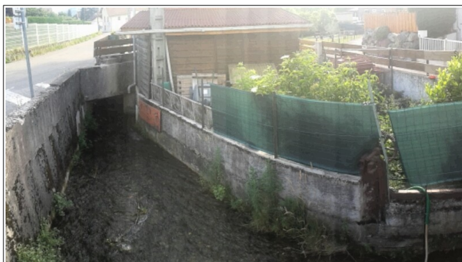
Photo 5: Entrée du Vernon dans le second passage souterrain.
