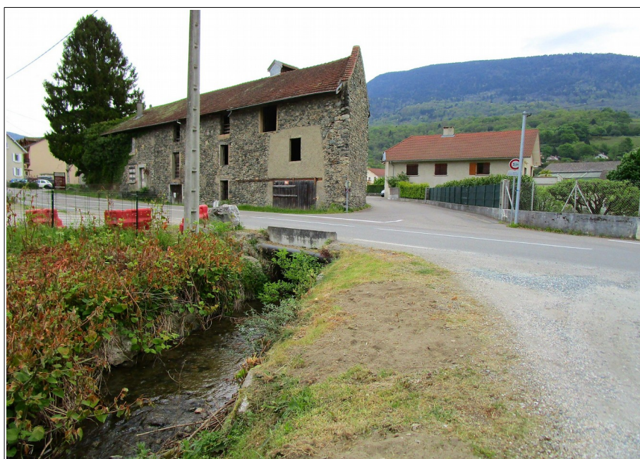
Photo 6: Ancien Moulin et sortie du Vernon de son deuxième passage sous-terrain.
