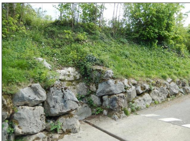
Photo 27: Enrochements et cunette d'évacuation des eaux de ruissellement sur le chemin de l'Adret.
