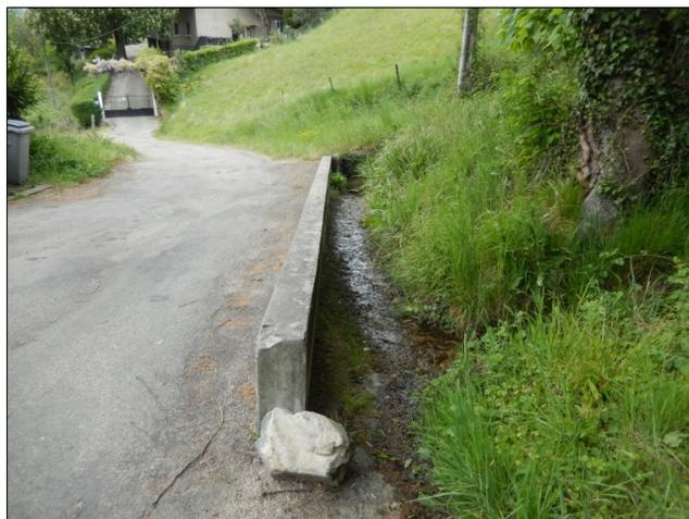
Photo 12: Buse et murette permettant le passage du ruisseau du
