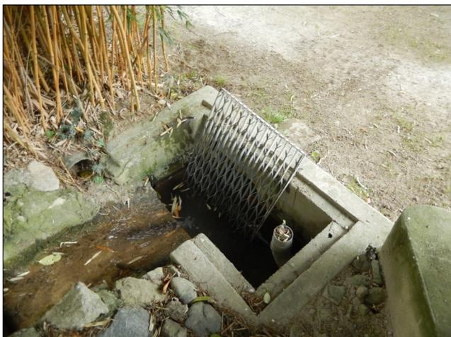
Photo 11: Buse permettant le passage du ruisseau du Perroud
