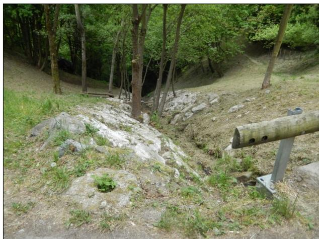
Photo 14: Enrochements sur les berges du ruisseau du Perroud à l'aval du chemin des Combasses.
