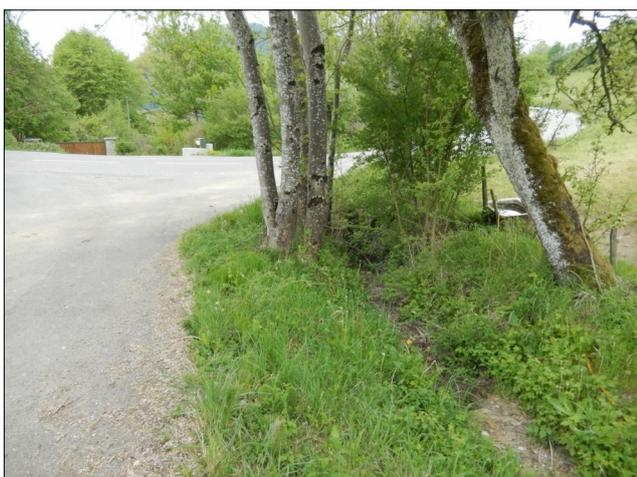
Photo 17: L'amont de la buse permettant l'évacuation des ruissellements vers le ruisseau des Combasses est envahi par la végétation.
