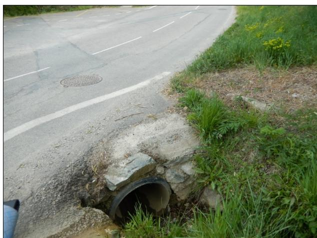
Photo 16: Buse permettant l'évacuation des ruissellements provenant du Chapon vers le ruisseau du Bit.
