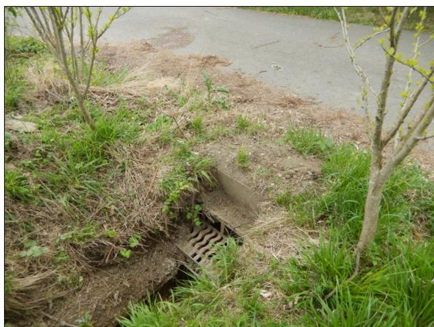
Photo 10: Buse permettant le passage du ruisseau du Perroud
