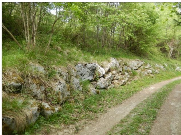
Photo 26: Enrochements à l'aval de la VC164 entre Reyné et Les Cochettes.
