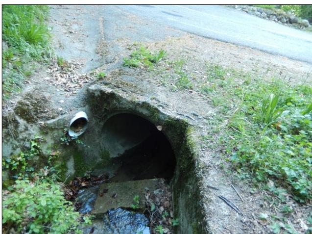
Photo 9: Buse permettant le passage du ruisseau des Combasses
