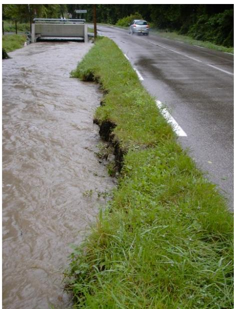
Photo 13 : Érosion de la rive droite à l'amont du pont des Berthets (crue du Vernon le 13-09-2008)
