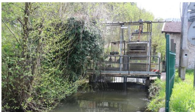
Photo 16 : Dégrilleur sur le Canal de Vaulnaveys au droit du « Virage-de-Mutte »
