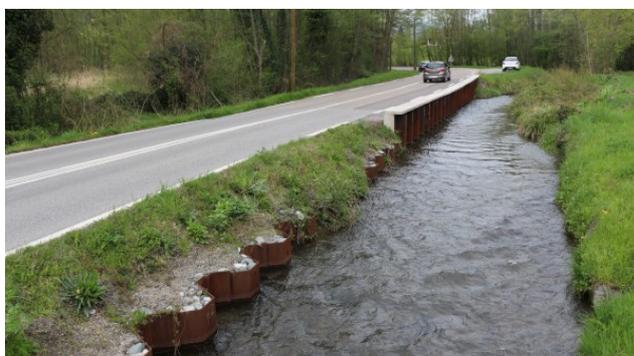
Photo 15 : Protection de berge en palplanches en amont du pont des Berthets
