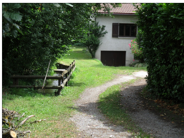
Photo 8: Garage en sous-sol pouvant être inondé en cas de débordement du ruisseau
