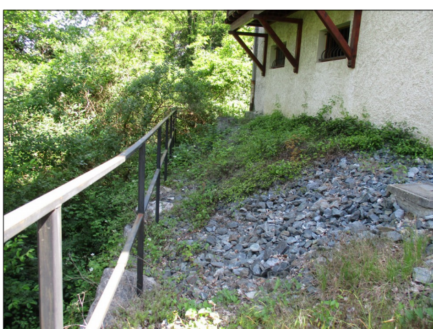
Photo 11: mur de soutènement à l'aval de la maison
