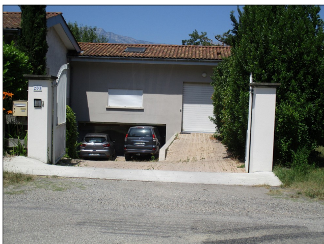
Photo 7: Garage inondé lors de l'événement du 20 juillet 2014
