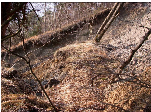
Photo 15 : Niche d'arrachement du glissement de terrain de 2009 à l'amont de la route de Savoyères (photo RTM).
