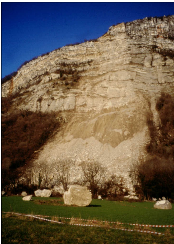
Photo 16 : Éboulement en masse de la falaise de Comboire en 1995 (photo Alp'Géorisques).
