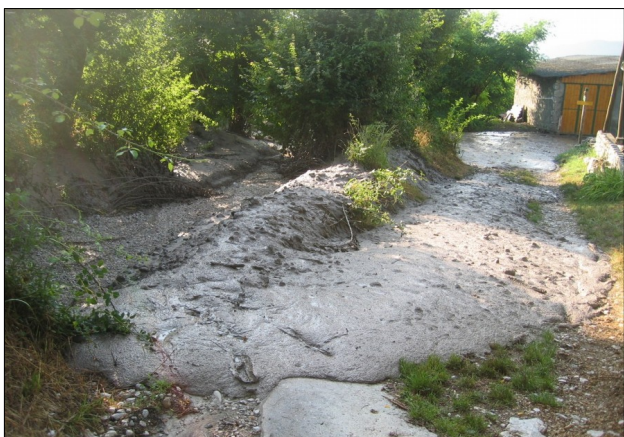
Photo 7 : Crue du Rif-Talon en 2006 à Malhivert : vue des débordements au niveau du pont du chemin des Acacias à la décrue (photo RTM).
