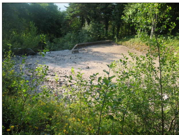
Photo 12 : Crue du Rif-Talon en 2006 : vue amont de la plage de dépôt RTM complètement remplie (photo RTM).
