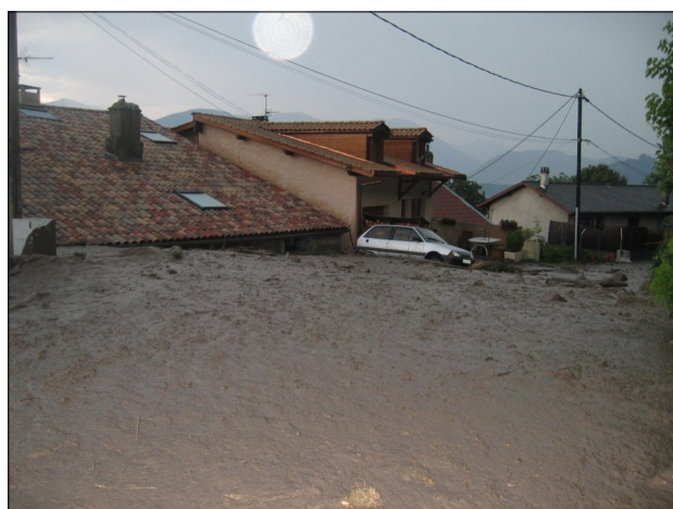
Photo 4 : Crue du Rif-Talon en 2006 à Malhivert : transit des laves torrentielles au niveau du passage souterrain (photo RTM).
