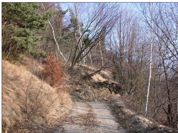
Photo 13 : Glissement de terrain de 2009 à l'amont du chemin de Savoyères (photo RTM).
