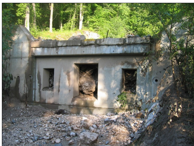
Photo 11 : Crue du Rif-Talon en 2006 : vue aval de la plage de dépôt RTM complètement remplie (photo RTM).
