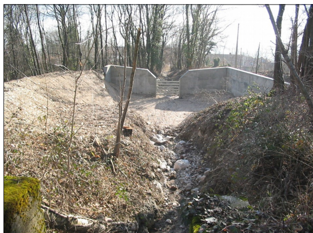
Photo 14 : Plage de dépôt communale "Gampas" à l'amont du chemin des Acacias à Malhivert (photo RTM).
