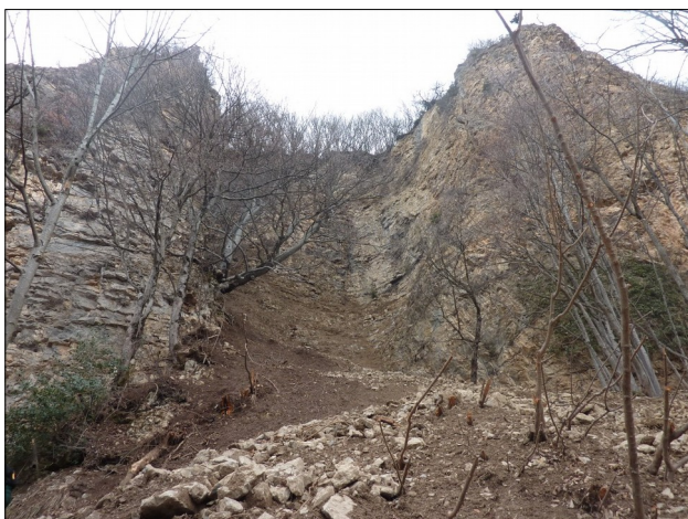
Photo 19 : Éboulement aux Rochers-Roux en 2013 : vue de la zone de départ (photo RTM).
