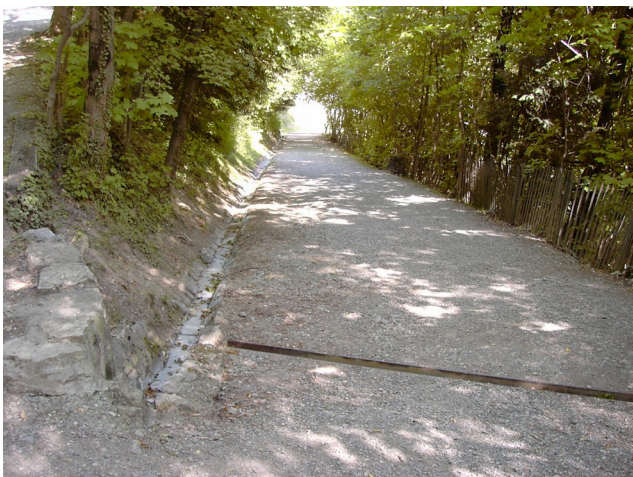
Photo 3 : Cunette et renvoi d'eau sur les chemins de La Bastille
