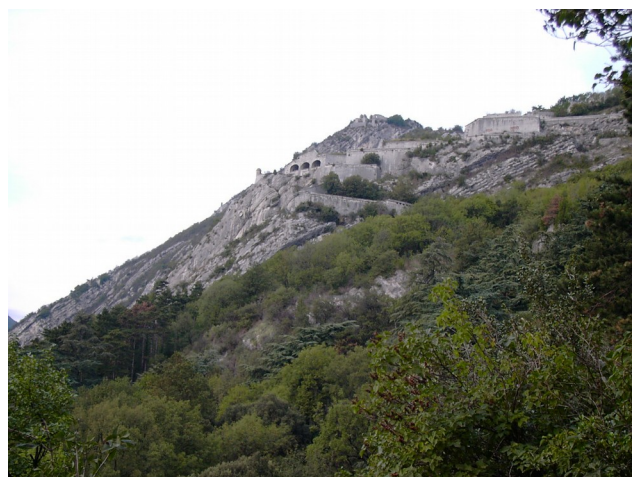
Photo 15 : Affleurement ouest à l'aval du Fort-de-La-Bastille
