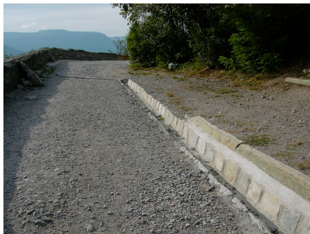
Photo 2 : Cunette et renvoi d'eau sur les chemins de La Bastille.
