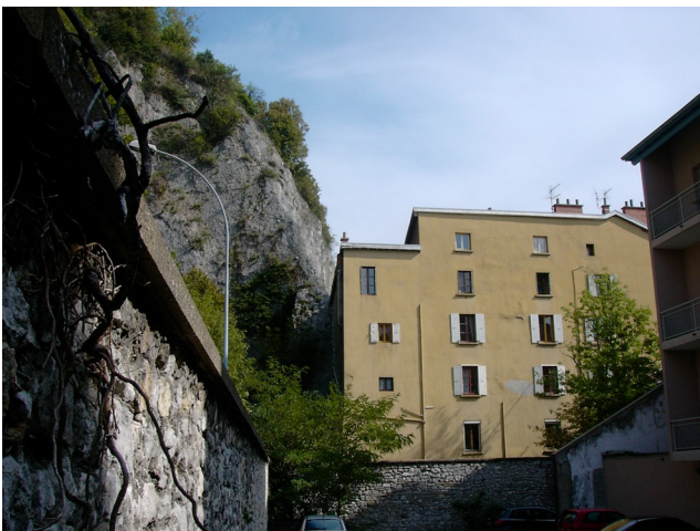
Photo 27 : Immeubles du Quai-de-France installés en pied de falaise
