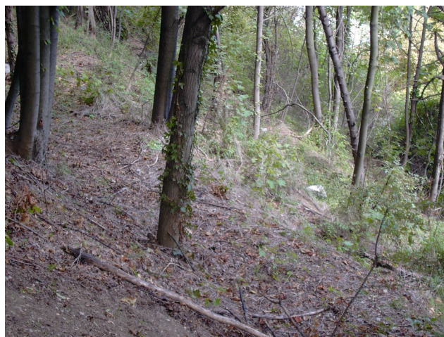
Photo 8 : Instabilité à l'amont de la Maison-Lionel-Terray
