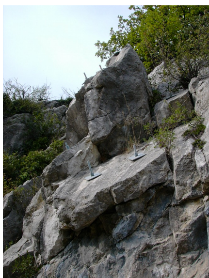
Photo 14 : Clouage de masses instables au-dessus des chemins de La Bastille
