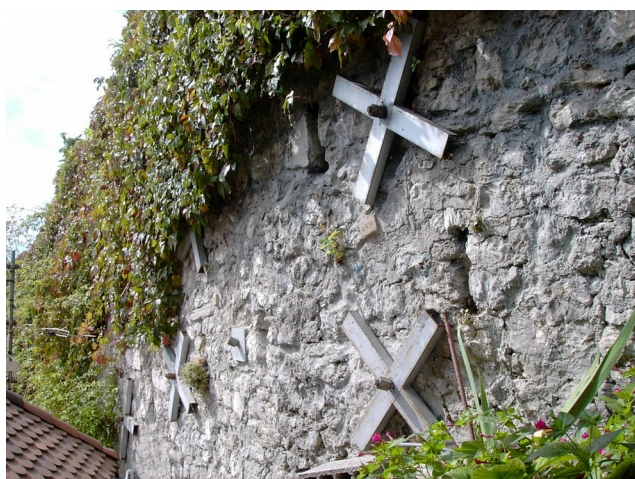
Photo 11 : Renforcement de soutènement à l'amont du 74, Quai Perrière
