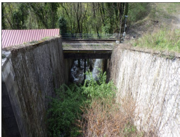
Photo 7 : Renvoi d'eau dans le fossé de défense ouest à l'aval de la RD57
