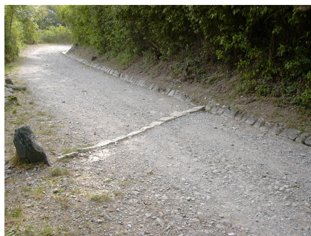
Photo 4 : Cunette et renvoi d'eau sur les chemins de La Bastille
