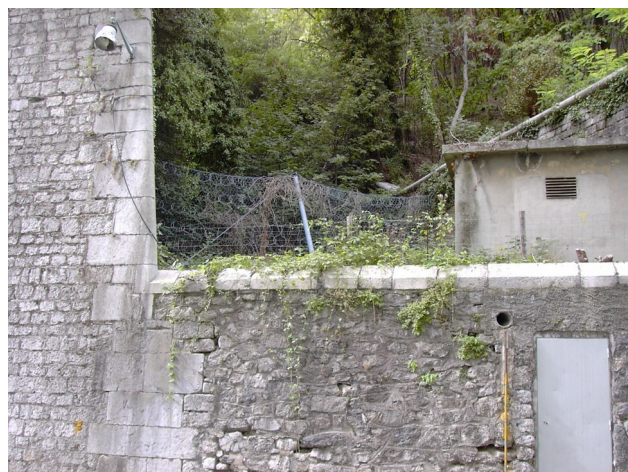
Photo 32 : Filet ASM au débouché du fossé est
