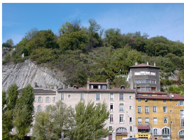
Photo 10 : « Glissement » du 74, Quai Perrière.
