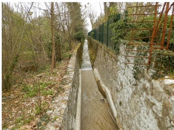
On notera que sur ce tronçon dit « DU CARMEL », le torrent coule entre des digues, au-dessus du terrain naturel. Ces digues en maçonnerie de pierres sèches présentent en général une butée en terre (cf. figure suivante). De grands arbres se sont développés en tête de ces remblais et pourraient occasionner des dégâts importants aux protections en cas de renversement (tempête). La digue rive gauche apparaît généralement plus basse et plus fragile qu'en rive droite.
