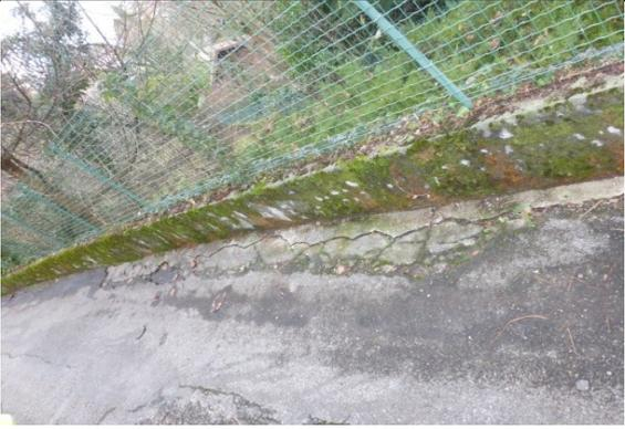
Une photographie d'un muret en béton qui semble fissuré. À côté, une route asphaltée est affaissée et présente des fissures. Une clôture en grillage vert est visible en arrière-plan.                       |
