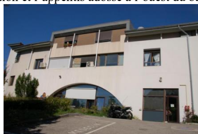
Façade moderne (protection supprimée)
