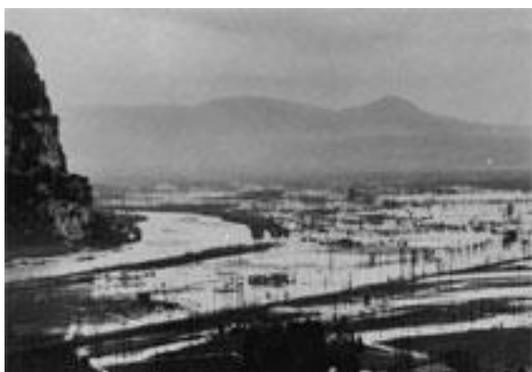
1948 : rupture de digue de l'Isère au Bec de l'Échaillon et inondation de plaine
