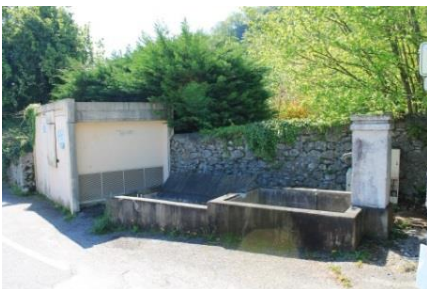
1-Le patrimoine d'eau sur la rue du Maupas
