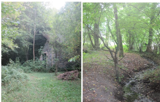
Ancienne micro- centrale et fossé sur le site de projet
