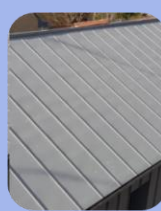
Toiture en zinc
