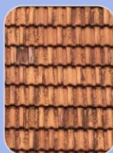
Toiture en tuile
