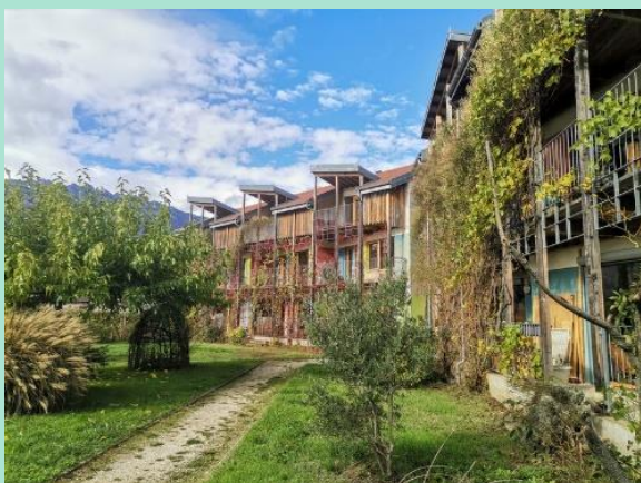
CONSTRUCTION NEUVE Un mur végétal épais Grenoble, Lycée des Eaux Claires source AURG
