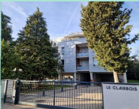
Grenoble, Le Clairbois Vue sur la façade sud du bâtiment source AURG
