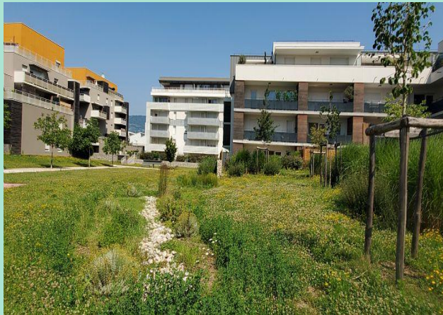
Noue végétalisée et arborée participant à la gestion des eaux pluviales Saint-Egrève, le Domaine du Châtelard source AURG
